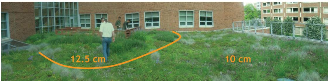
**Εικόνα 3.** Διαφορά στη σύσταση των φυτοκοινοτήτων ανάλογα με το βάθος του υποστρώματος το οποίο διαφοροποιείται μόλις 2,5 cm (Penn State University, USA, Building of Forestry Dept.) (Αρχείο Δρ. Π.Α. Νεκτάριου).
